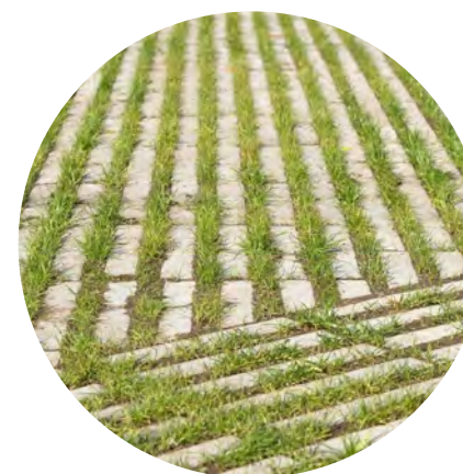
1 parkovací stání - zatravnovací dlažba
