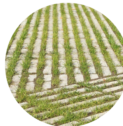
1 parkovací stání - zatravnovací dlažba
