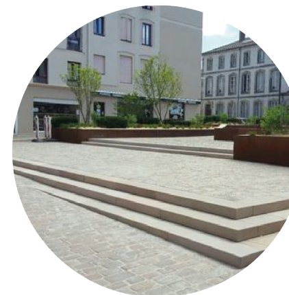
3 piazzetta - kamenná dlažba a schody
